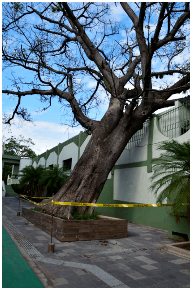
Figura 4: Árbol a punto de caer sobre la calzada. Fuente: QUADRATIN (2018)
