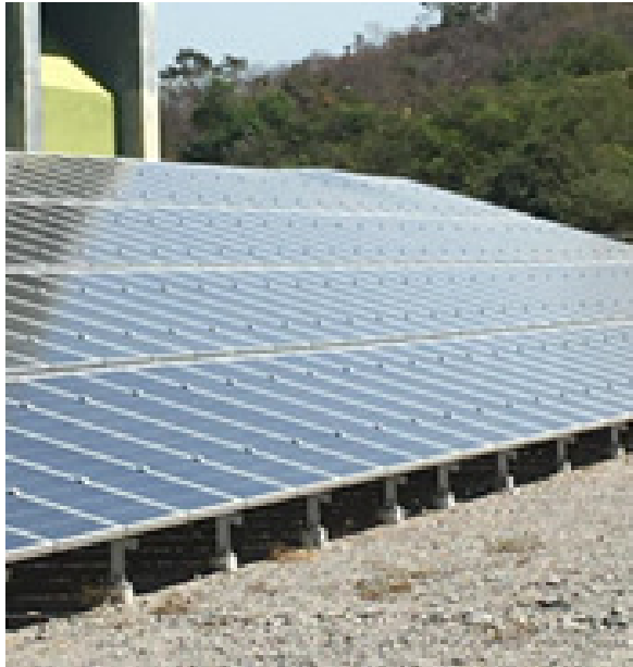
Figura 3: Estructura desalineada
