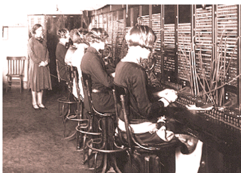
Figura 1. Central telefónica (1920's).
