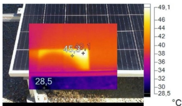
Figura 7: Delaminación de panel
