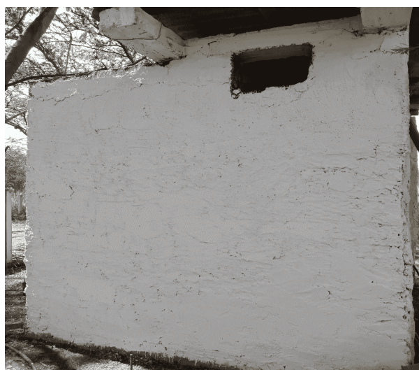
Figura 3: Superficie pintada con pintura ecológica de nopal y cal
